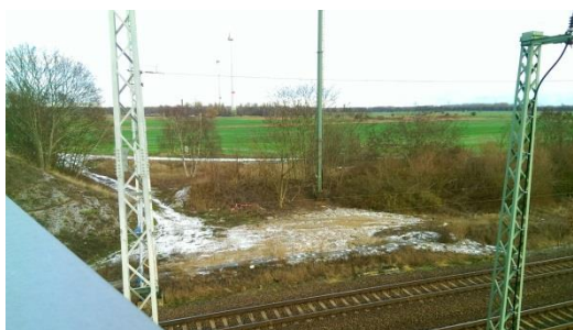
7: Blick auf das Gelände von Südwesten (Schönerlinder Brücke)
